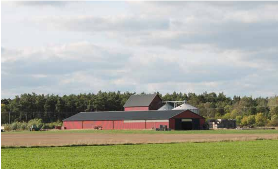
Spannmålstork och silo uppförda 1999 i Kastlösa.
