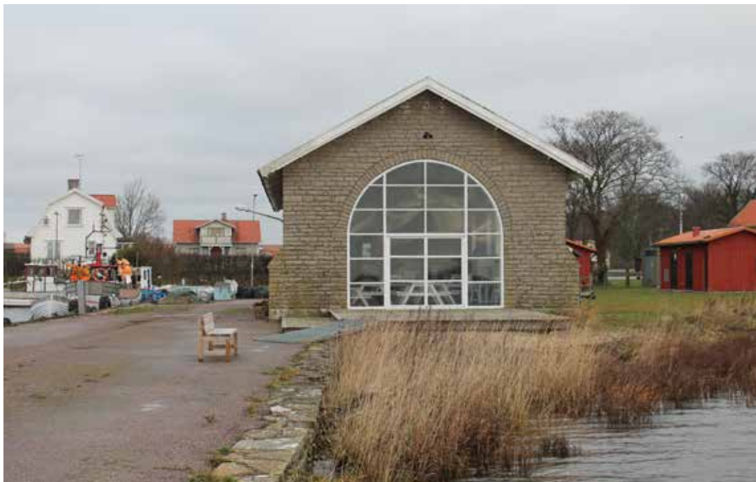
Livräddningsstationen i Grönhögen kom till på privat initiativ 1912. Samma år sjösattes livräddningsbåten Drottning Victoria och det välbyggda båthuset i kalksten uppfördes. Stenen som huset uppfördes av var återanvänd sten från en tidigare station. Idag finns kafé och galleri i byggnaden.
