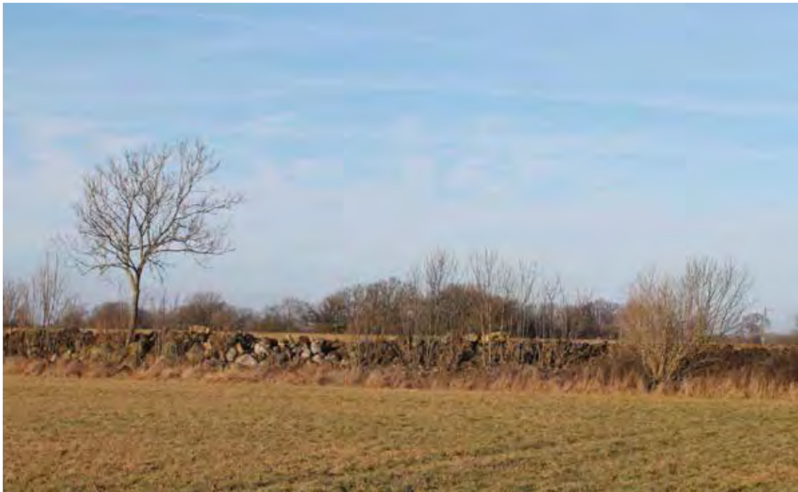
Nedra Ålebäck. Del av Nedra Ålebäcks gärdesmur. Gärdet ligger bakom muren.
