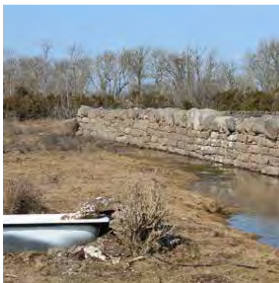
Ur en källa pumpas vatten upp för att fylla badkaret. Ekelunda, Sandby socken.
