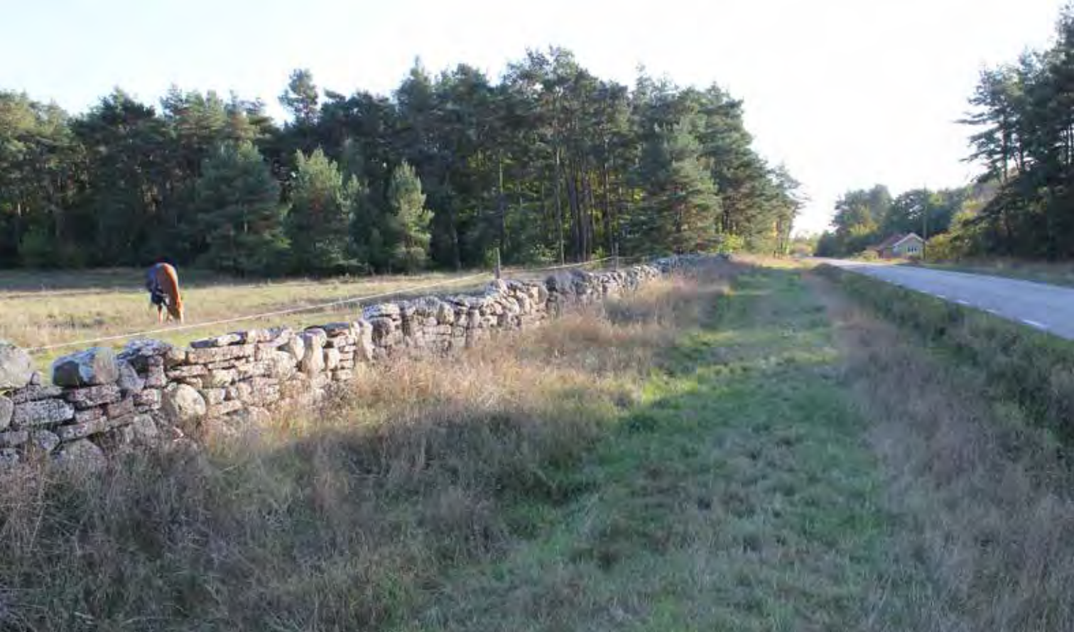
Beteby, Mörbylånga socken. Längs den nedre landsvägen väster om gårdet återstår 362 meter av muren. Gårdet till vänster i bilden.
