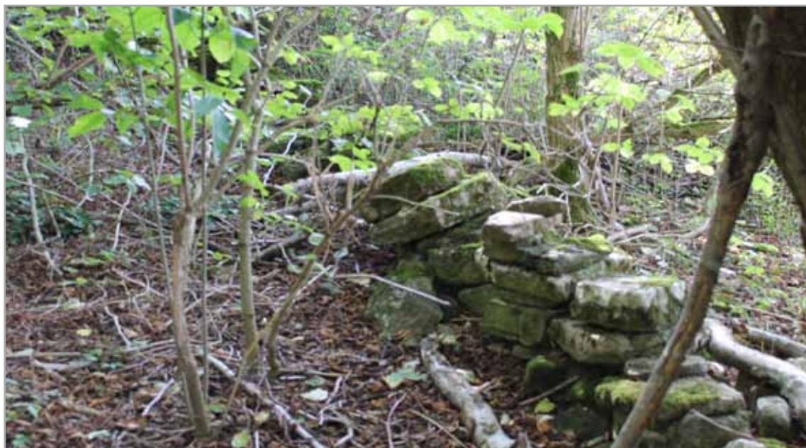
Kleva. Nedanför landborgen, där det inte odlats upp, finns rester kvar efter den gamla gårdesmuren.
