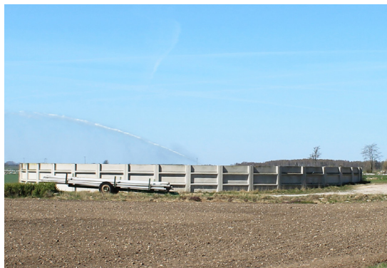
Gödselvårdsanläggningarna måste vara så stora att de rymmer lagring av gödsel i åtta månader. Foto: Ann Moreau
