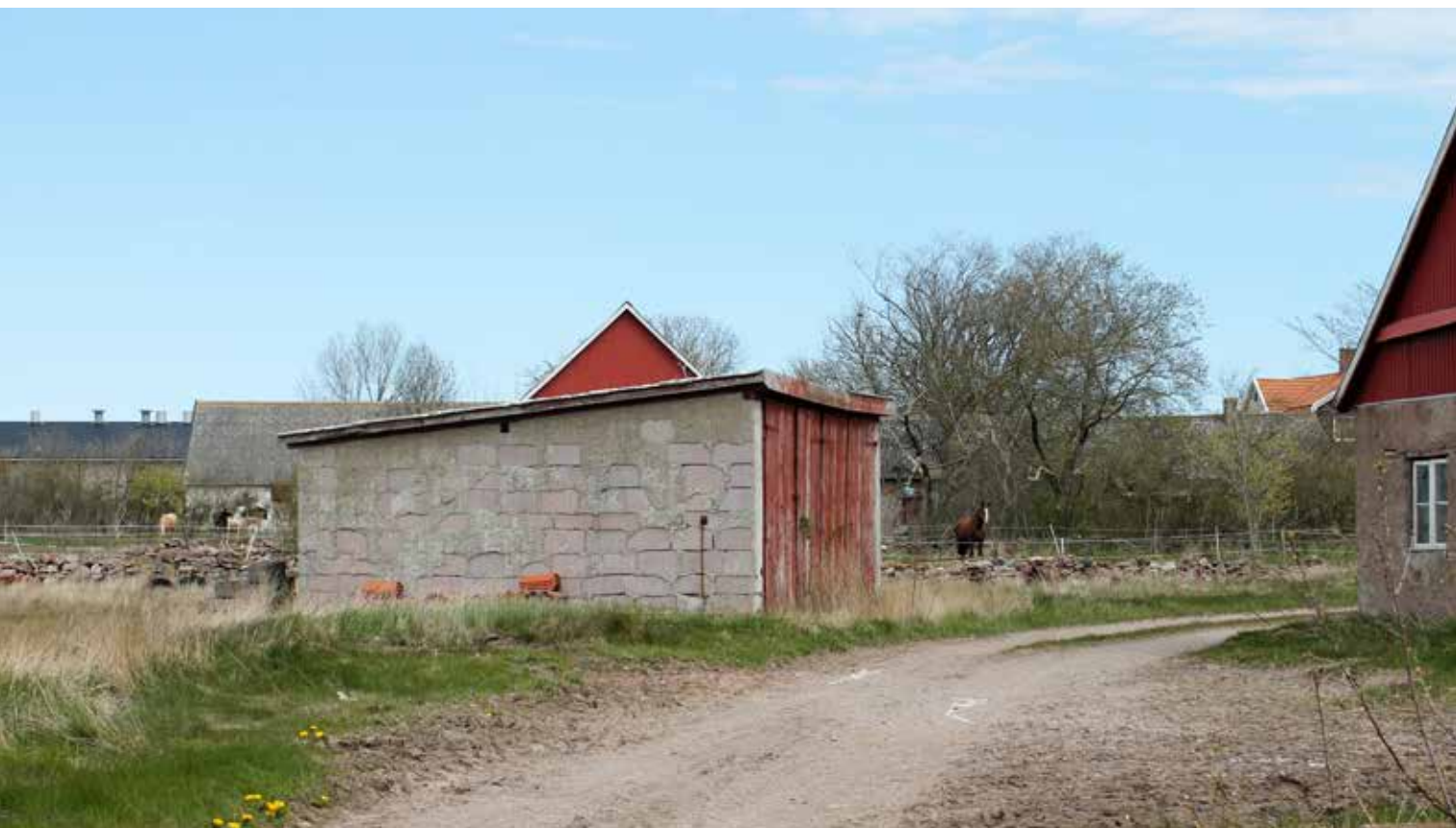
Sekunda block från Ytongfabriken i Grönhögen kom till användning i många hus på södra Öland. Traktorgaraget på bilden är sedan länge urvuxet. Lindby.
