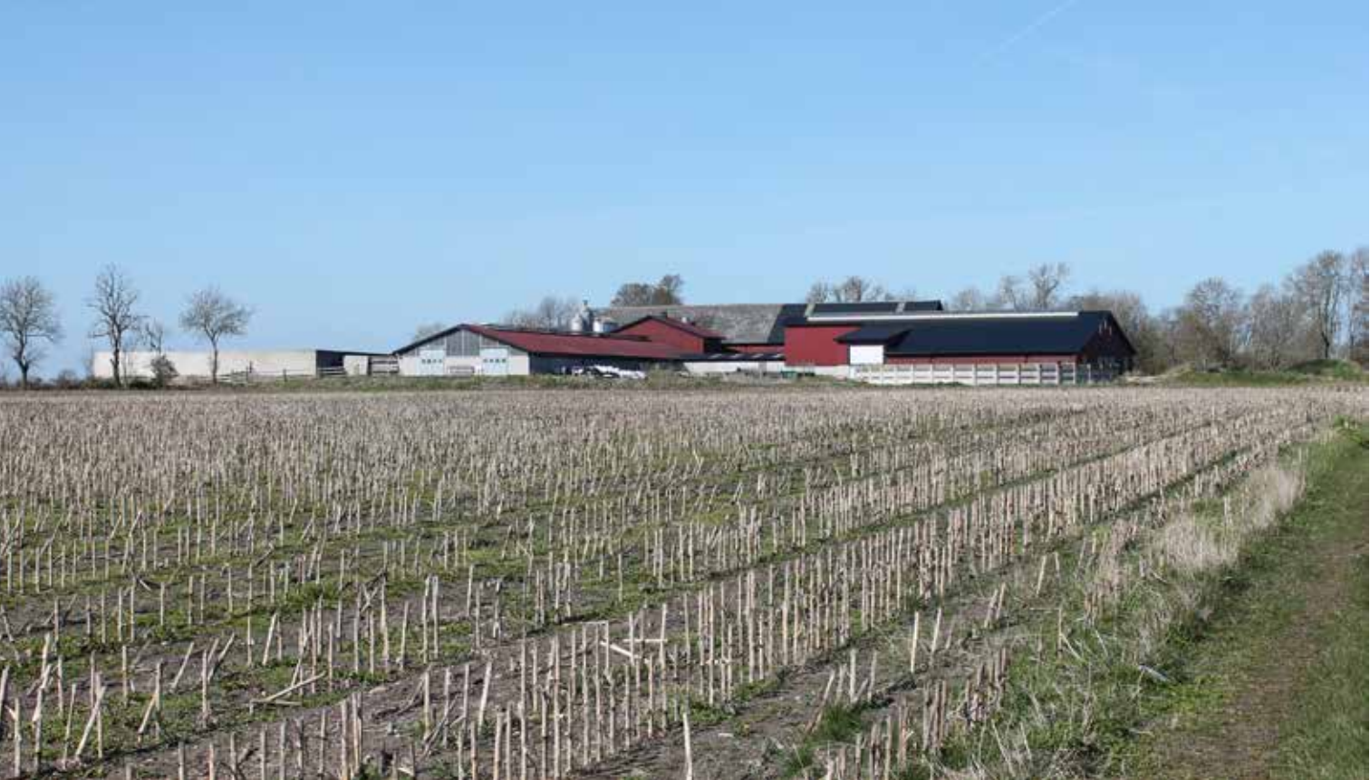
De stora ekonomibyggnaderna har sedan 1980-talet med nödtvång hamnat utanför bytomterna för att ge expansionsmöjligheter och en fungerande logistik. Här ses 2000-talets hallar framför 1900-talets höghus. Norra Kvinneby, Stenåsa socken.
