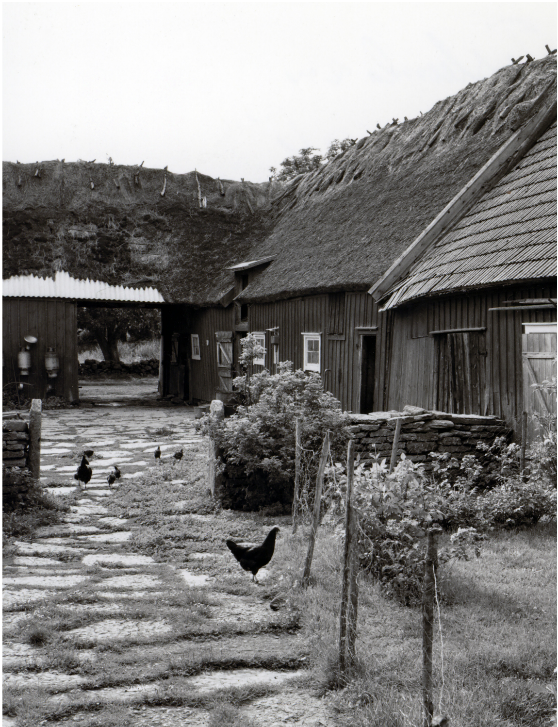
Innergård med lador och sidobyggnader. Trädgårdens buskar och blommor är inhägnade med kycklingnät för att få skydd från hönsen som går fritt. Kalkstad, Torslunda socken 1957. Foto Nils J Nilsson/Kalmar läns museum
